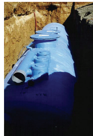
Depósito de recogida de aguas grises Y pluviales.
