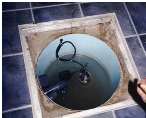
Interior del depósito recolector donde va instalada la bomba
